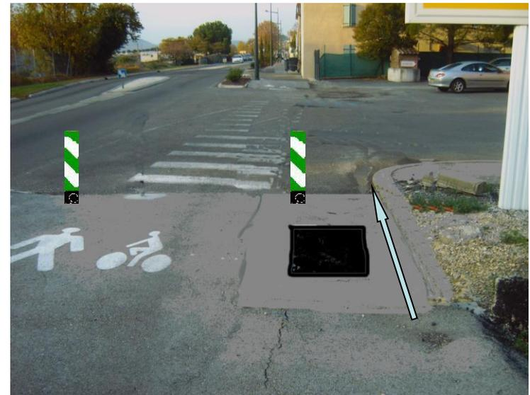
La proposition est de couvrir par une dalle amovible le collecteur d'eau avec le cas échéant un regard avec possibilité d'évacuation des eaux pluviale sur la partie droite de la dalle coté magasin
