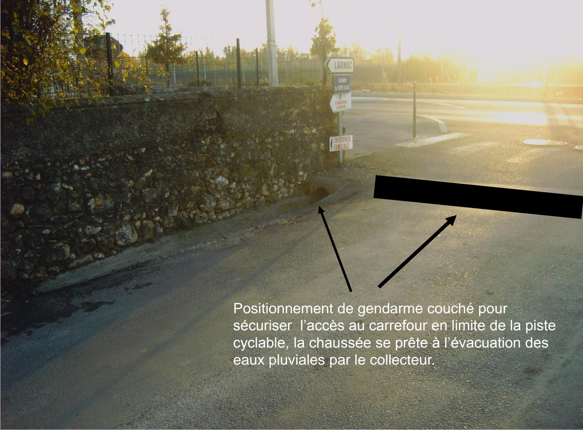
Positionnement de gendarme couché pour sécuriser l'accès au carrefour en limite de la piste cyclable, la chaussée se prête à l'évacuation des eaux pluviales par le collecteur.
