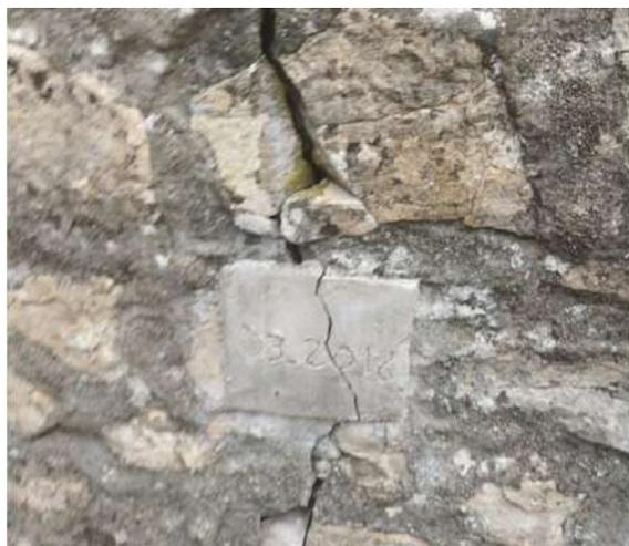
Le pont fait état d'une surveillance suite à des fissures de part et d'autre du pont qui semble de contenir au garde-corps
